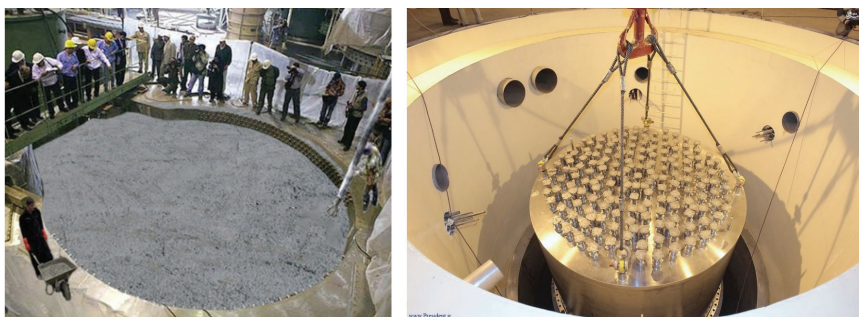
התמונה השמאלית: הפוטושופ אשר לפיו מיכל כור המים הכבדים IR-40 התמלא בבטון (האיש האוחז במריצה, בתחתית תמונה זו מצד שמאל, נראה מרחף מעט מעל פני הקרקע); התמונה הימנית: מבט מלמעלה על מיכל כור המים הכבדים כאשר בתוכו ליבת הכור.
